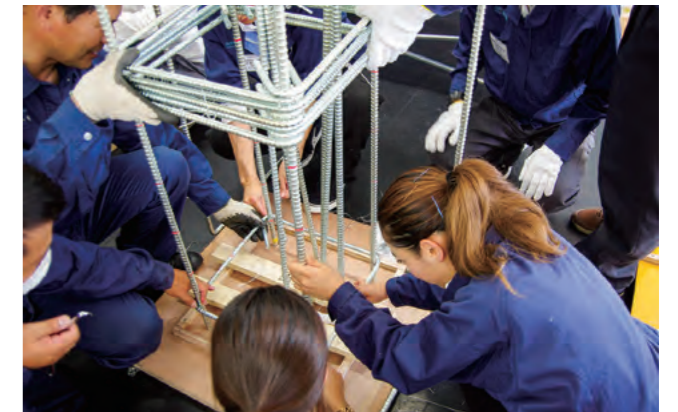
鉄筋型枠組立実習
