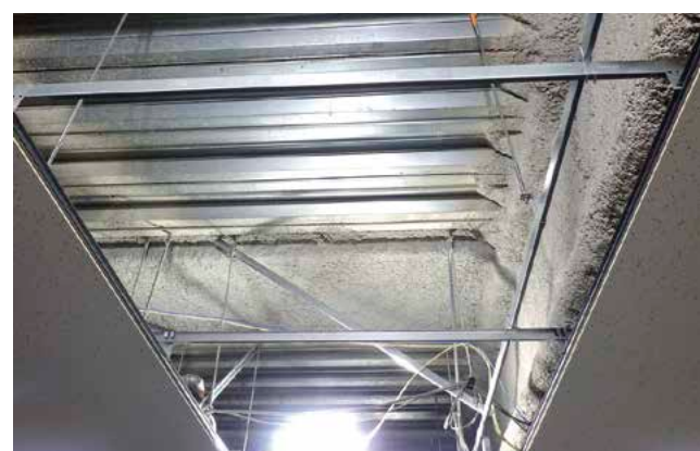
天井フタコロ(天井内部施工状況)
